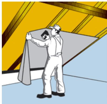
На внутренней поверхности стропил степлером закрепляются полотнища пароизоляционной пленки «ЮТАФОЛ Н СИЛЬВЕР», полотнища укладываются внахлест и герметично соединяют клейкой лентой. После этого можно установить внутреннюю облицовку.
